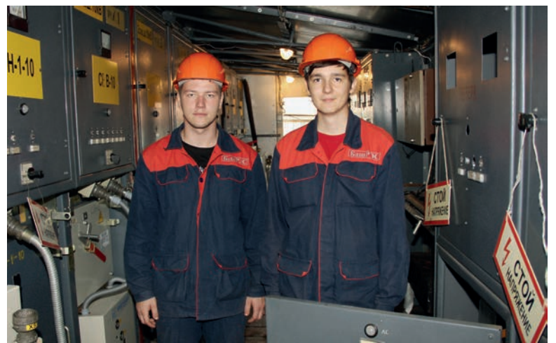
Выпускники Уфимского топливно-энергетического колледжа Ефим Харитоненко и Спартак Бикбаев, пройдя в мае производственную практику в отделе РЗА ПО «УГЭС» ООО «Башкирэнерго», сегодня работают электромонтерами по ремонту аппаратуры РЗА.
